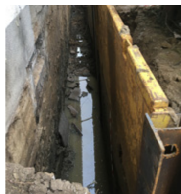
Remonty budynków i kamienic, wymiana izolacji, osuszanie
