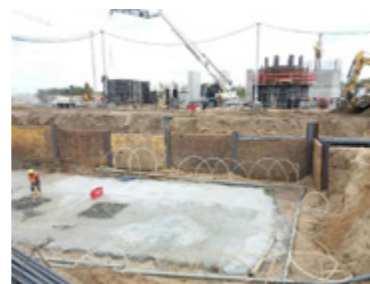
Wykop szerokoprzestrzenny pod budynek
