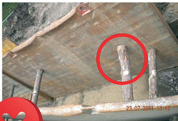
Rys. 16. Należy stosować rozwiązania systemowe, rozpory systemowe
