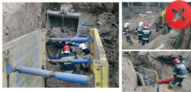
Rys. 6. Kilka zdjęć z akcji ratowniczej. Pracownik znalazł się w strefie pomiędzy boksami. Nieprawidłowy dobór obudowy doprowadził do zasypania pracownika. Błędy te w większości dotyczyły lekkich obudów, które stosowane są na znacznych głębokościach bez jakiegokolwiek weryfikacji parcia gruntu, bez uwzględnienia jakichkolwiek dobrych praktyk z dokumentacji DTR czy przepisów BHP. Za każdym razem przed przystąpieniem do prac zalecamy bezpłatne konsultacje z doradcami Koproas
