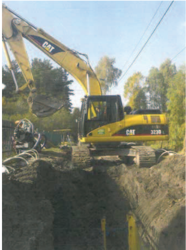
Rys. 4. Widok wykopu o głębokości 5 m zaszalowanego boksami o wysokości 2 m z nadstawką 1,25 m
