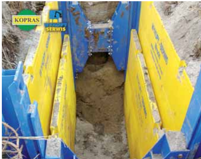
Fot. 5. Montaż płyt wewnętrznych i pogłębianie wykopu
