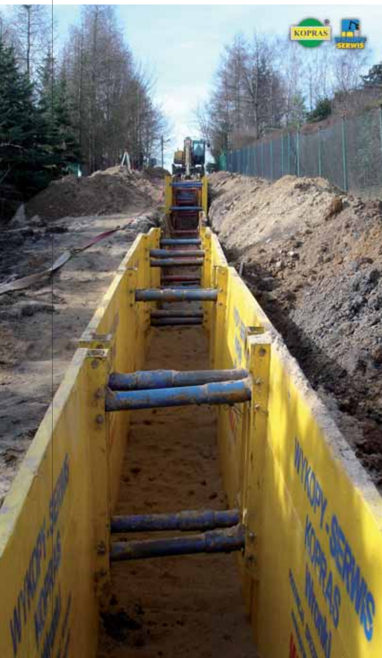
Fot. 1. Układ liniowy posadowienia boksów
